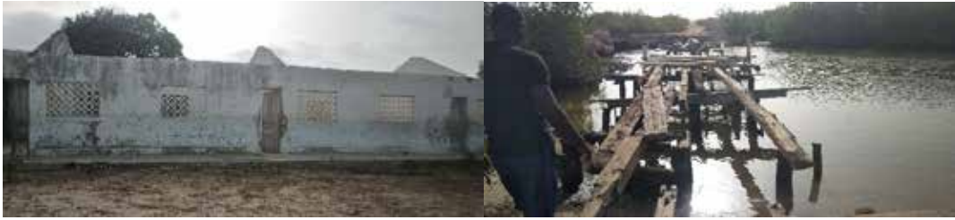
Figura 3 Estrutura atual da Escola em Edgim e ponte do trecho Suzana/Varela
