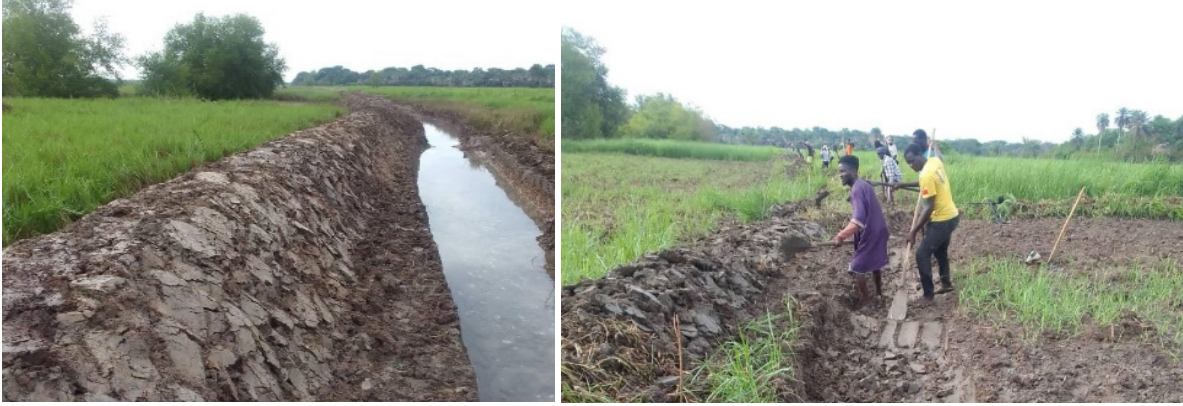
Foto 1: Obras de construção de diques manualmente/Empresa ACAT SARL
