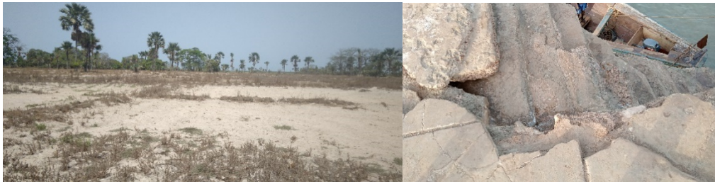
Figura 4 Estado atual de bolanha em Djufunco e rampa de cais em Bolama
