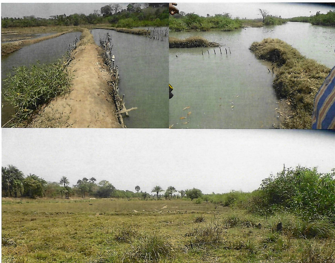
Foto 6: Dique de proteção precária, construído pela comunidade e zona de evasão de água salgada
