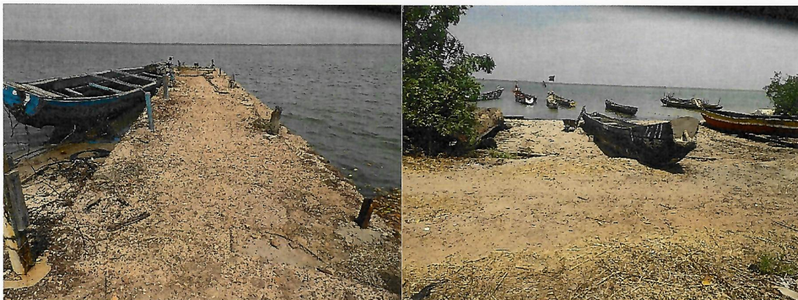
Foto 4: Rampa construída na época de escravatura e espaço para construção da nova rampa
