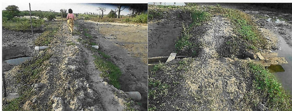
Foto 2: Diques de proteção na bolanha de Dapak
