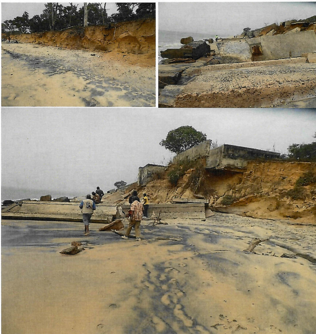
Foto 5: Praia de Varela - elevado nível de erosão costeira
