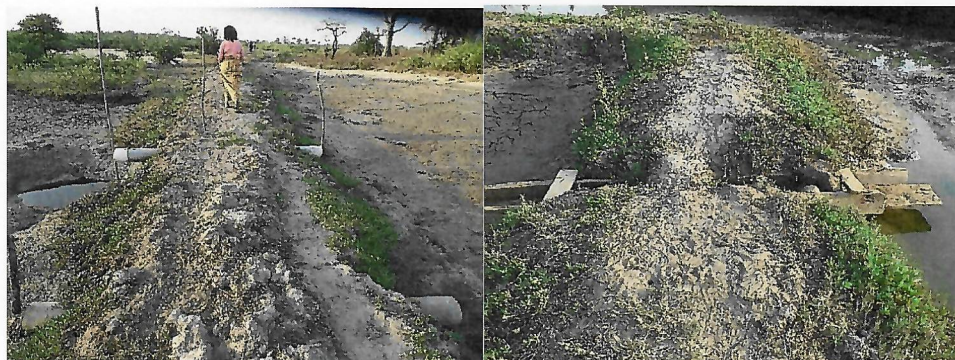
Foto 2: Diques de proteção na bolanha de Dapak
