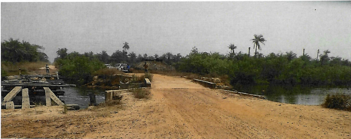
Foto 7: A ponte existente construída de madeira e ponte alternativa construída em betão armado diminuindo a área de passagem de água
